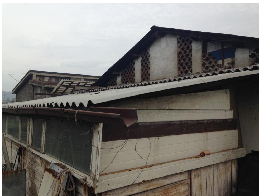
Foto 2.2 – Lastre in cemento amianto
