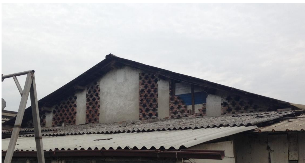
Foto 2.1 – Lastre in cemento amianto
